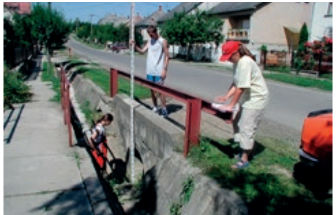
Szendehely, csatornázás előkészítés - 2002.
