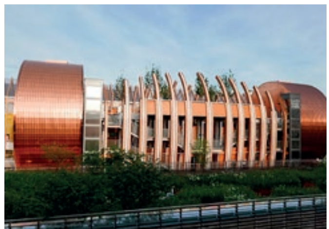
Milánói világkiállítás. Magyar pavilon létesítés műszaki ellenőrzése, 2015.
