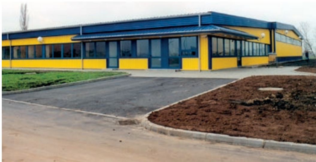
Jászárokszállás, 3.600 m 2 -es elektronikai üzem. Megbízó: Carlberg & Son Kft. - Svédország Tervezés-kivitelezés.
