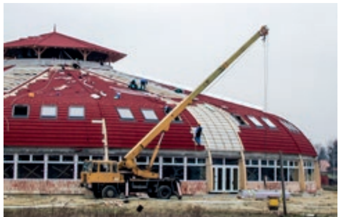
Kisterenye, tanuszoda építés - 2005.
