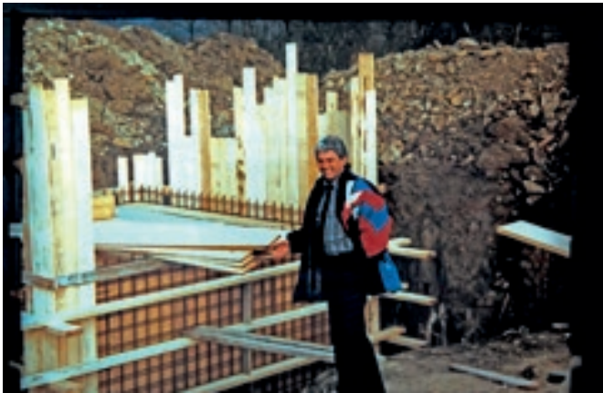
Hollókő víztároló medence építése - 2003.
