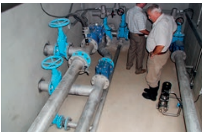
Kálló víztároló új zárkamra ellenőrzése - 2004.
