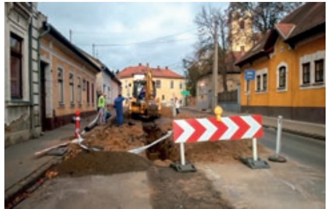
Balassagyarmat ivóvíz rekonstrukció - 2015.
