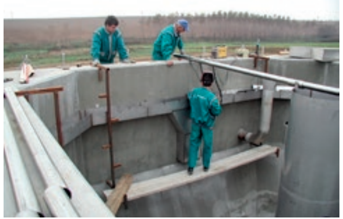
Érsekvadkert, szennyvíz tisztító telep építése - 2001.
