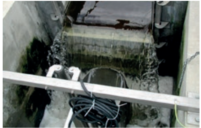
Salgótarján felújított szennyvíz tisztító telep, tisztított szennyvíz kivezetés - 2003.
