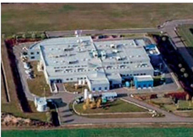
Rétság AFT fémmegmunkáló üzemcsarnok létesítés 3 ütemben (2001, 2003, 2005), tervezés, műszaki ellenőrzés
