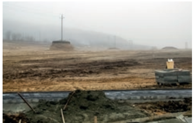
Salgótarján, Ipari Park II. ütem építése - 2000.
