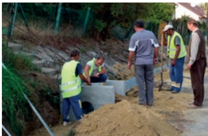
Kazár, csapadékcatorna építés - 2006.
