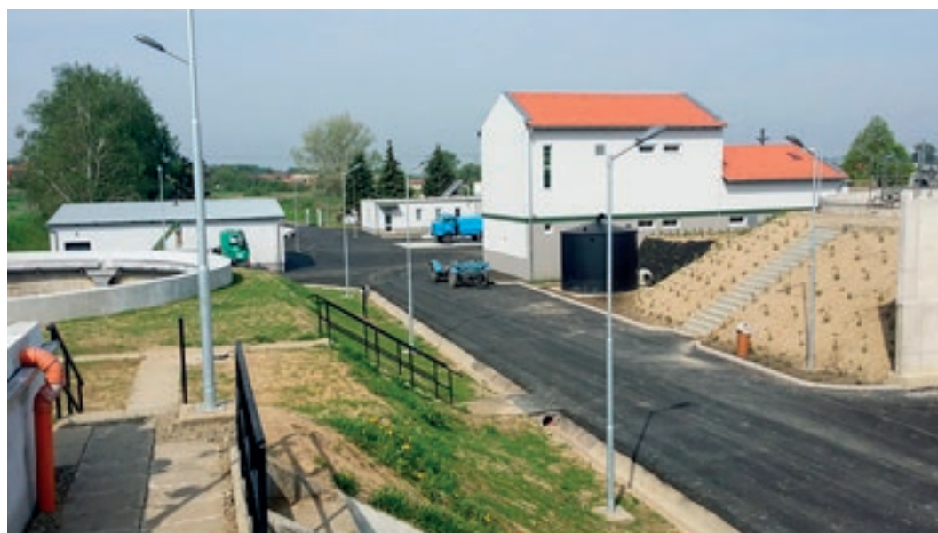
Szécsényi szennyvíztisztító telep felújítás után
