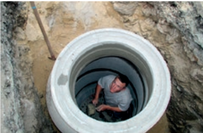
Rétság, csatorna rekonstrukció - 2002.
