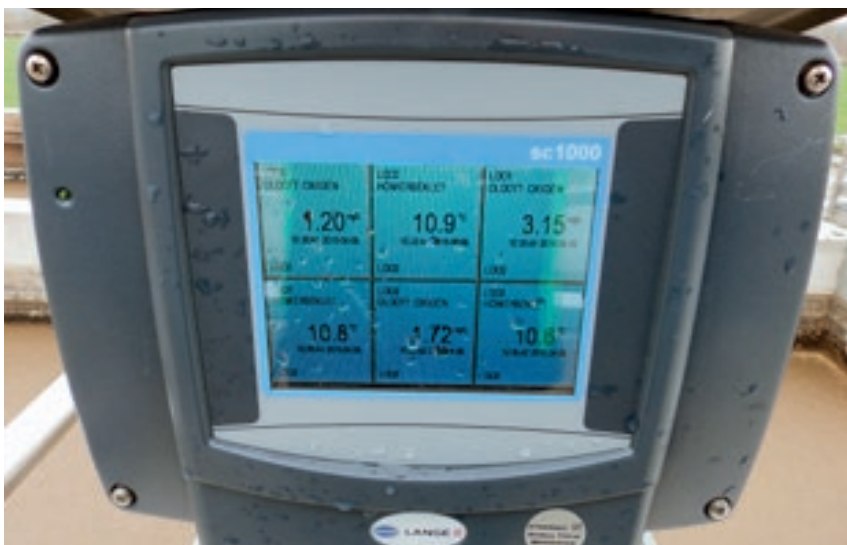
Nagylózsi szennyvíz tisztító telep – egyesített műtárgy helyi kijelzője
