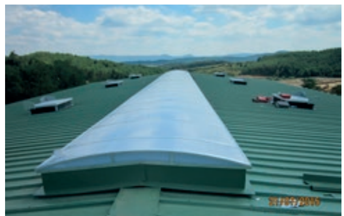
Kupolák és sáv-felülvilágító szerelés közben 2015. július 21.
