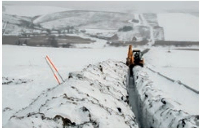
Kazár, külterületi csatorna építése - 2002.
