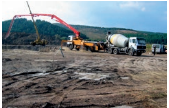
Mátraterenye, szennyvíz tisztító telep építése - 2006.
